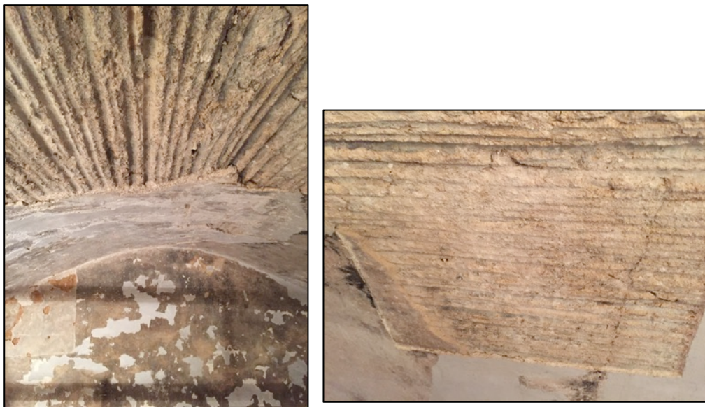
Fotografies 108 i 109. Detalls dels encanyissats voltes UE1008 i UE1009.
