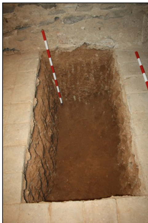
Fotografia 4. Cala oberta en estança A1 per a la construcció de la fonamentació de la nova escala. Es documenta el terreny natural UE101.
