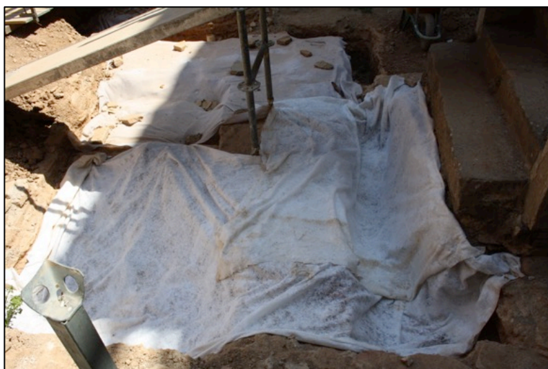
Fotografia 39. Cobriment amb geotèxtil de les estructures documentades en el pati.
