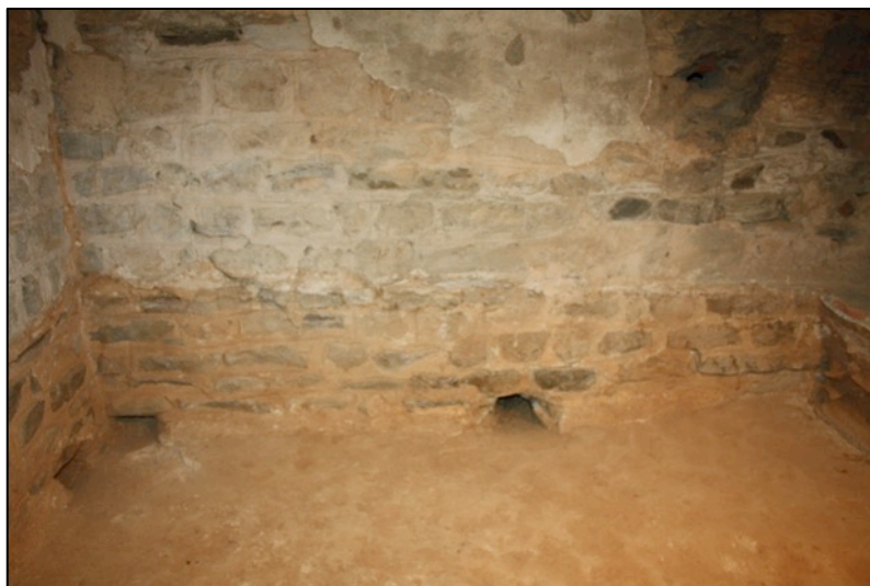
Fotografia 133. Detall dels desaigües localitzats en la zona del paviment UE1078.
