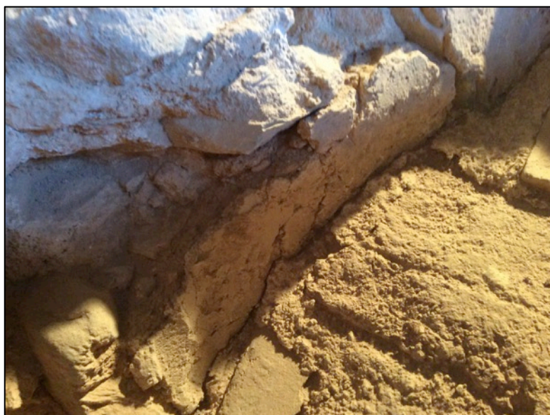
Fotografia 139. Detall enlluït en la zona del forat d'accés al pis superior torre.
