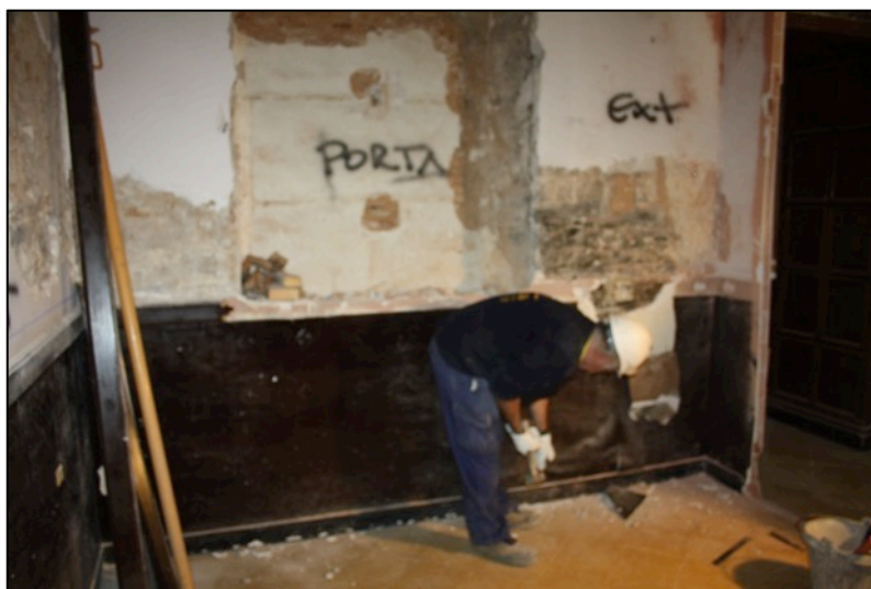
Fotografia 79. Treball d'extracció elements contemporanis zona interior torre.
