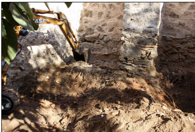
Fotografia 62. Rebaix nivell superficial UE539.
