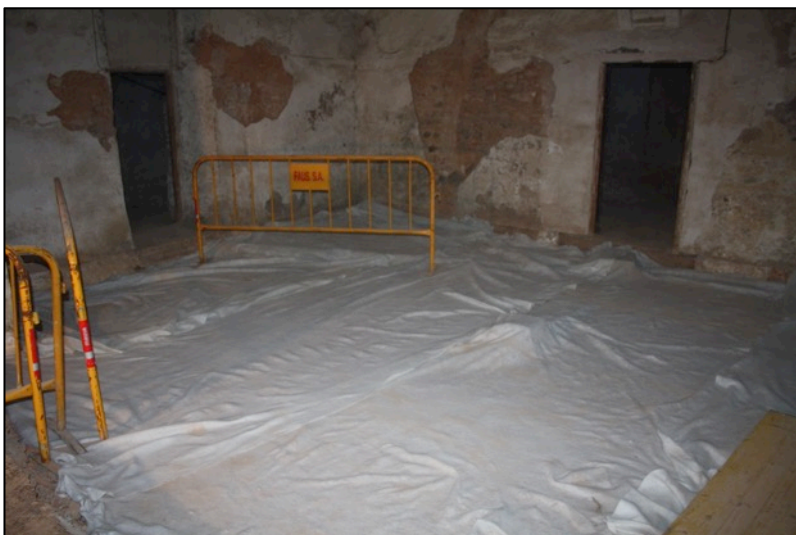
Fotografia 166. Cobriment estructures zona premsa documentades intervenció 2009.
