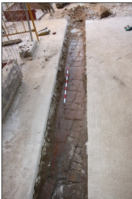
Fotografia 9. Paviment de maons UE165 datat en el segle XIX. Es documenta en obertura de rasa per serveis en A2.
