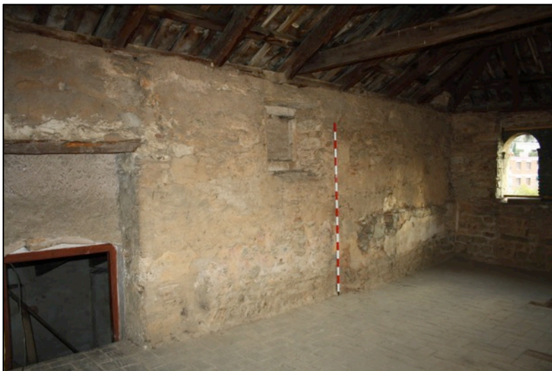
Fotografia 126. Murs UE1001 i UE1105 amb finestra s. XVII tapiada i porta d'accés al pis superior de la torre UE1109.
