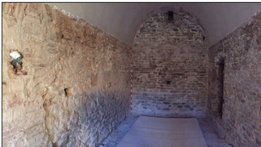
Fotografia 71. Zona interior planta inferior torre.
