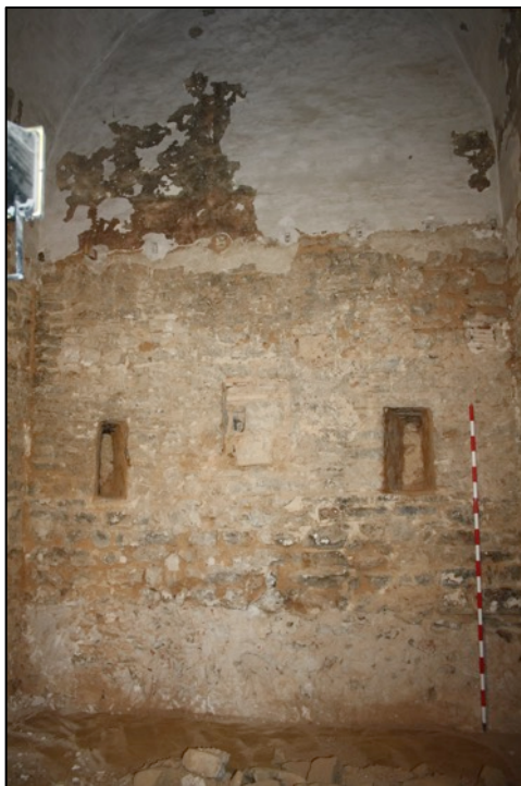
Fotografia 82. Mur occidental torre UE1003. Vista interior amb espitlleres UE1024, UE1028 i finestra UE1049.
