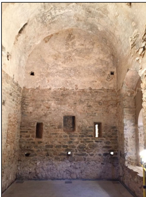
Fotografia 107. Vista del mur UE1003 restaurat amb enlluït UE1033 revestint volta romànica UE1008.
