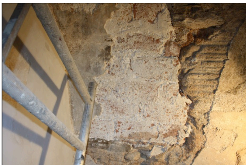
Fotografia 112. Detall forat accés pis superior torre tapiat amb maons UE1092 s. XIX.
