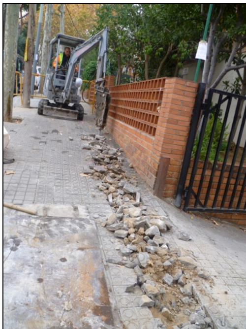
Fotografia 159. Obertura rasa serveis carrer Frederic Rahola.
