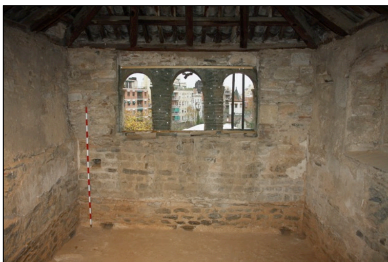
Fotografia 129. Murs UE1007 i UE1107 amb zona oriental pis superior excavada.
