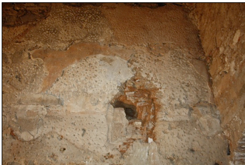
Fotografia 154. Detall agulla mur de tàpia.
