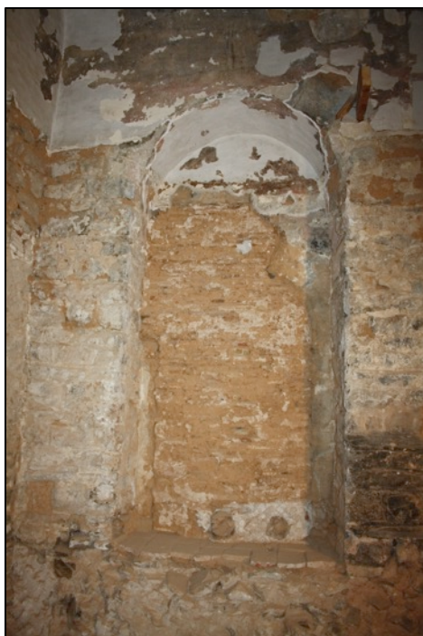
Fotografia 92. Vista de la porta d'accés a la torre amb tapiat del segle XVII.
