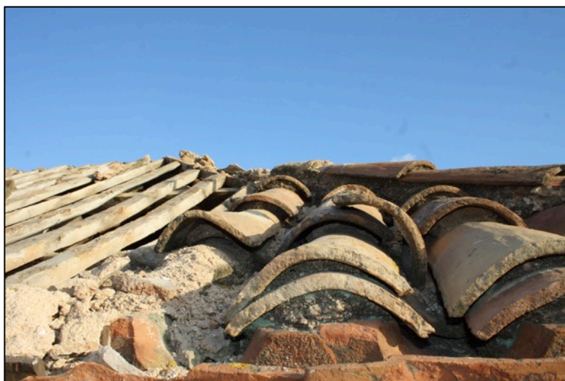
Fotografia 150. Detall teules originals de la coberta de la torre, s. XVII.
