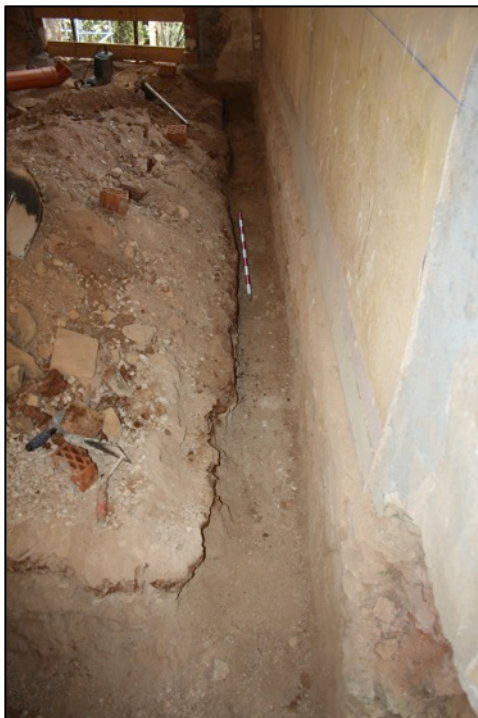
Fotografia 17. Rasa sanejament oberta en A2. Es documenta nivell de runa UE109.
