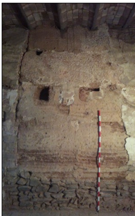
Fotografia 153. Vista en alçat del mur UE1201 amb tram de sòcol de pedra i tapial.
