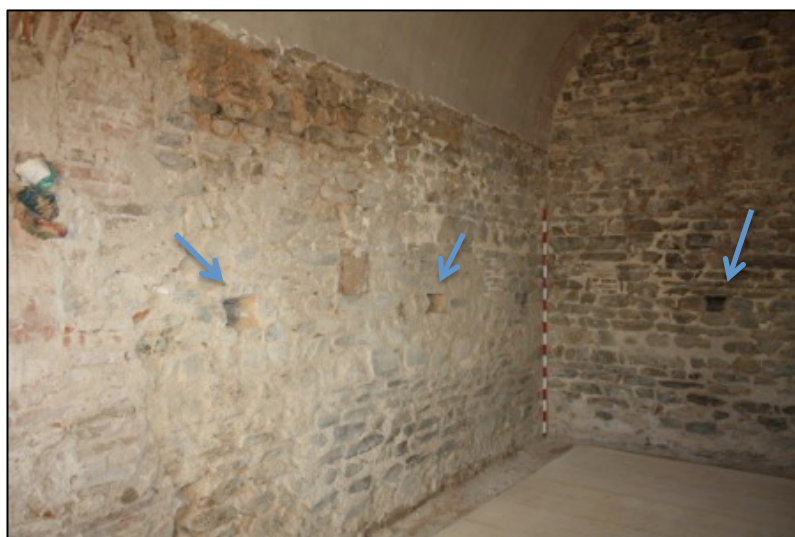
Fotografia 72. Vista d'alguns de forats de les bastides usades per construir la torre.
