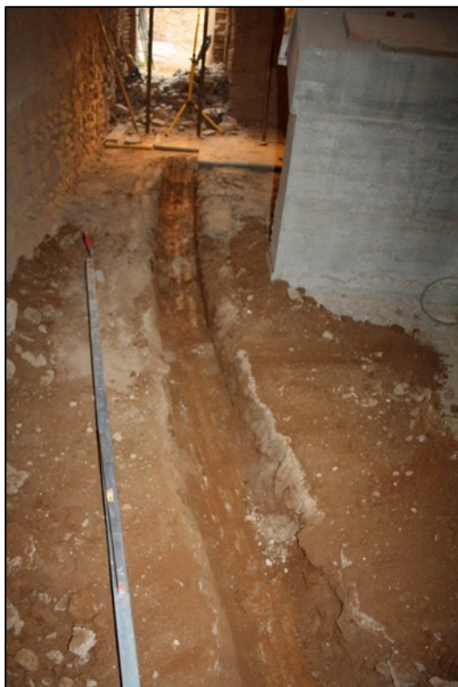
Fotografia 15. Rasa oberta a A1 i posteriorment tapada per variació en el traçat del sanejament.
