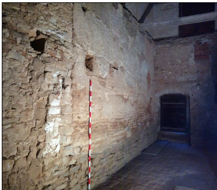
Fotografia 152. Cara sud mur de tàpia segle XIII.
