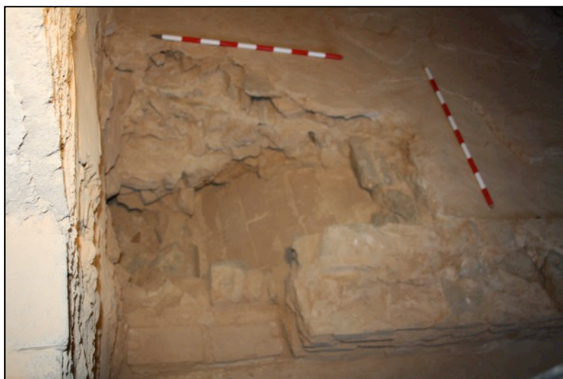
Fotografia 138. Detall tapiat amb maons s. XIX forat accés interior al pis superior torre.
