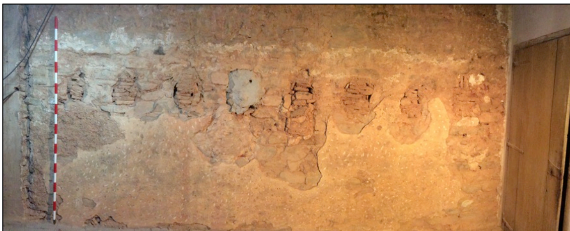
Fotografia 120. Enlluïts UE1112 segle XIII localitzats la cara externa del mur occidental de la torre.
