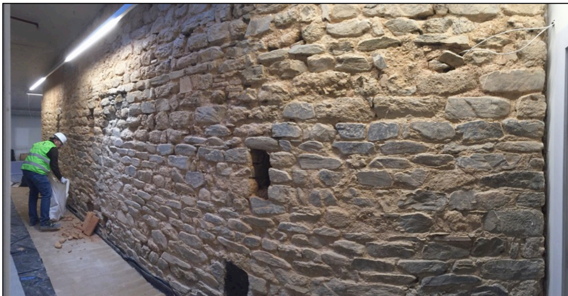
Fotografia 123. Procés de restauració mur UE1005. S'observen les tres finestres que donen llum a l'interior de la torre UE1044, UE1062 i UE1058 (de més lluny a més a prop de la imatge).
