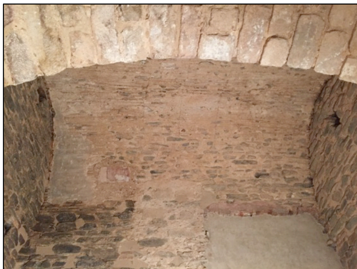
Fotografia 111. Vista volta UE 1009 amb encanyissat i restes de l'enlluït s. XIII-XIV UE1033.
