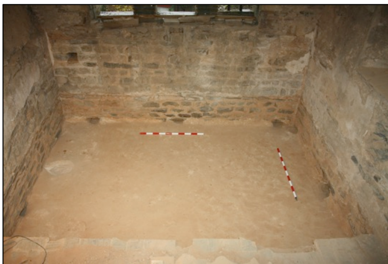
Fotografia 130. Vista del paviment medieval UE1078 en la zona oriental del segon pis de la torre romànica. També es poden observar els forats dels desaigües.
