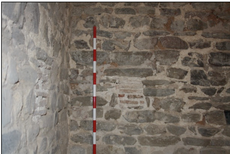
Fotografia 73. Detall d'una de les obertures de llum en el mur occidental planta baixa de la torre, UE1027.
