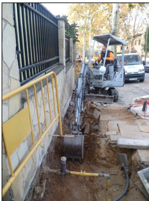
Fotografia 160. Aixecament paviment de la vorera UE2000.
