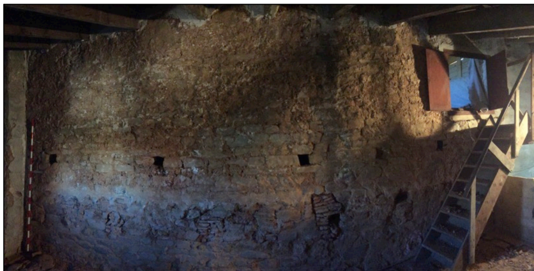
Fotografia 119. Vista cara externa mur nord UE1001 en el tram del pis superior de la torre.
