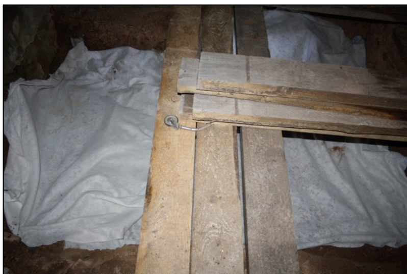
Fotografia 167. Cobriment estructures A3 documentades intervenció 2009.
