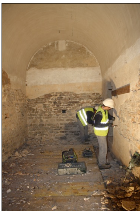
Fotografia 70. Treballs de repicat murs interiors torre.
