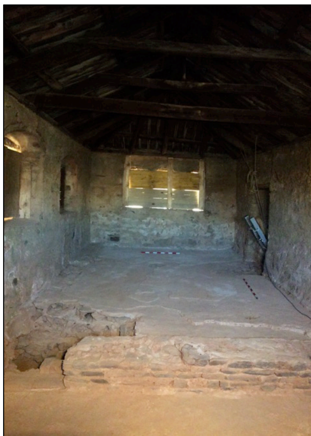
Fotografia 141. Vista general interior pis superior torre amb estructures medievals.
