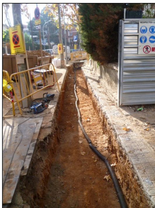
Fotografia 162. Vista general rasa oberta.
