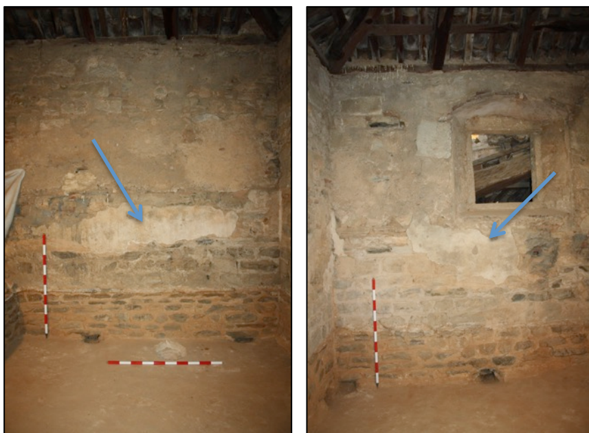
Fotografies 131 i 132. Restes de l'enluit segle XIX en diversos punts del pis superior de la torre, UE1159.
