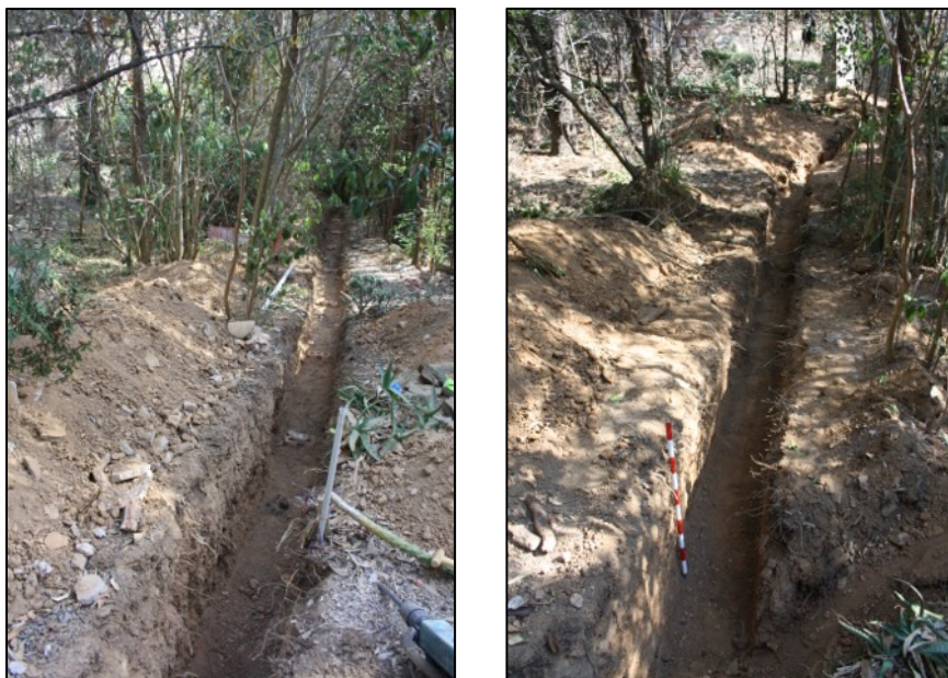
Fotografies 56 i 57. Diversos trams de rasa oberta en el jardí per a la instal·lació del nou sanejament.
