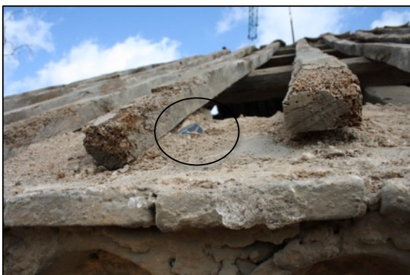
Fotografia 149. Ceràmica blava catalana en el morter de la coberta de la torre, s. XVII.
