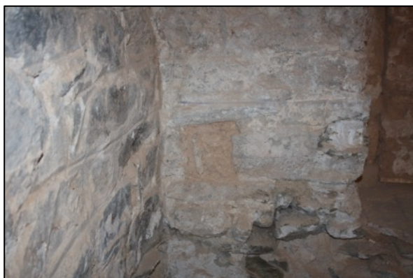
Fotografies 113, 114 i 115. Detall de diversos forats de bastida localitzats al llarg dels paraments de la torre. UE1150 amb restes de fusta.
