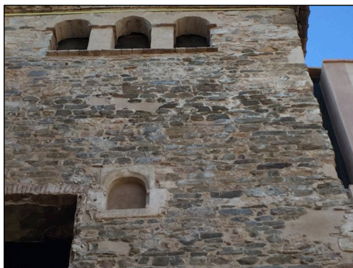
Fotografia 116. Mur est UE1007 amb finestra gòtica UE1103 un cop restaurats.
