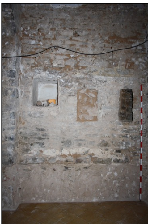
Fotografia 83. Mur nord torre UE1001. Vista interior amb espitlleres UE1019, UE1045 i finestra UE1037.
