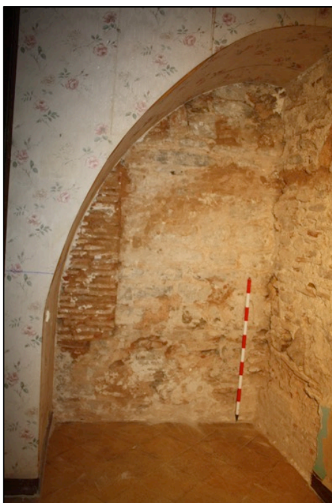
Fotografia 95. Vista porta accés torre parcialment tapada per escala d'accés al segon pis masia.
