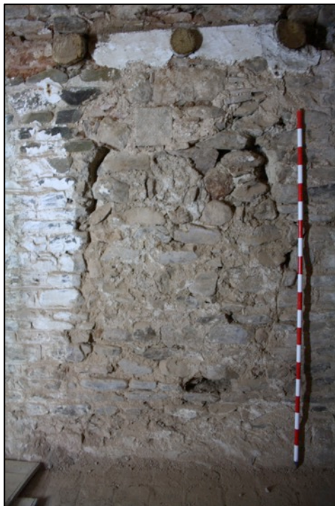
Fotografia 67. Vista des de l'exterior de la porta oberta en el mur nord de la torre en el segle XIII UE1066.
