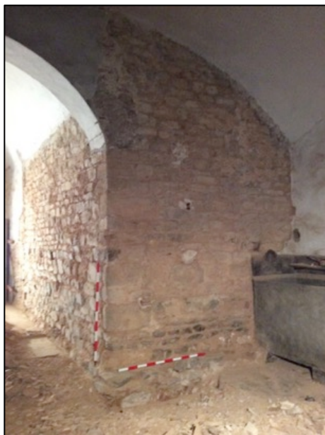
Fotografia 69. Murs occidental i meridional de la torre medieval en la planta baixa un cop repicats els paraments.
