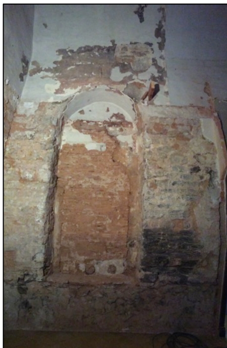
Fotografia 103. Vista de les diverses capes de pintures localitzades en la zona de la port romànica.
