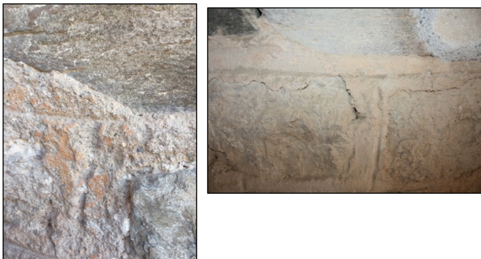
Fotografies 100 i 101. Detalls encintat pedres amb restes de pigments ocre.
