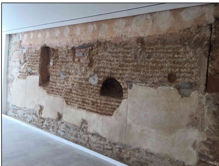
Fotografia 155. Cara externa mur de tàpia UE1201 restaurat amb finestra UE1203 i nínxol UE1204.
