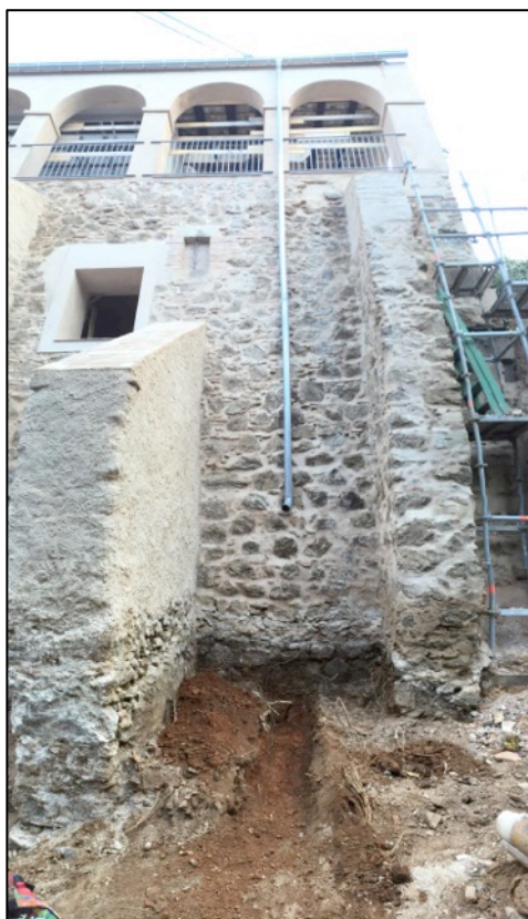
Fotografia 63. Obertura rasa recollida aigües pluvials de la coberta de la masia.
