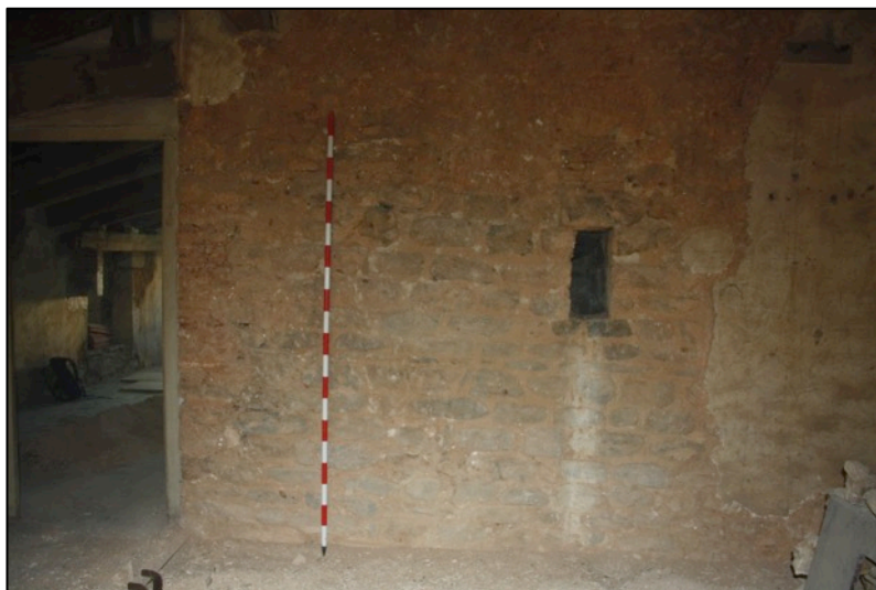
Fotografia 121. Cara externa mur sud UE1005 amb finestra UE1044.
