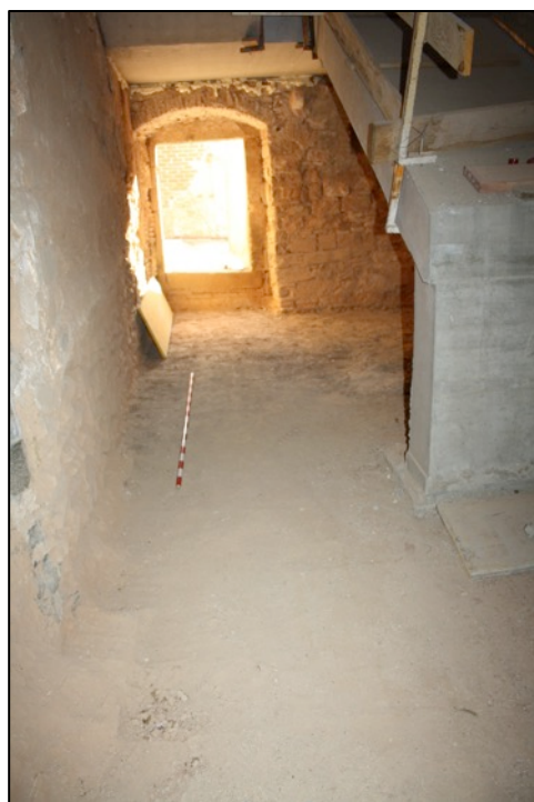
Fotografia 5. Interior A1 un cop aixecat paviment UE100.
