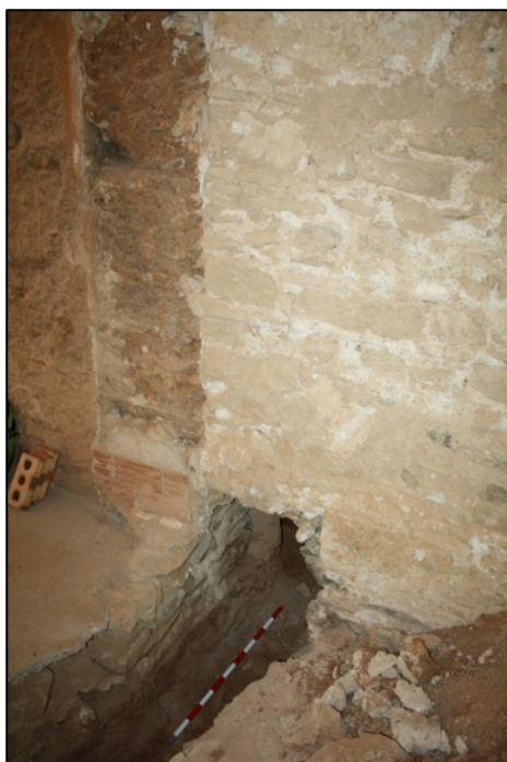
Fotografia 6. Localització del mur UE171 en rasa de sanejament oberta en A2.
