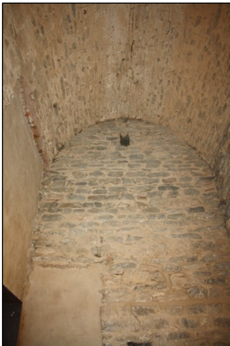
Fotografia 106. Vista del mur UE1005 restaurat amb volta de canó UE1009 i el negatiu de l'encanyissat.
