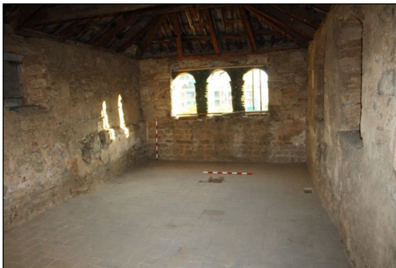
Fotografia 124. Vista de l'interior de la planta superior de la torre amb paviment segle XIX UE1072.
