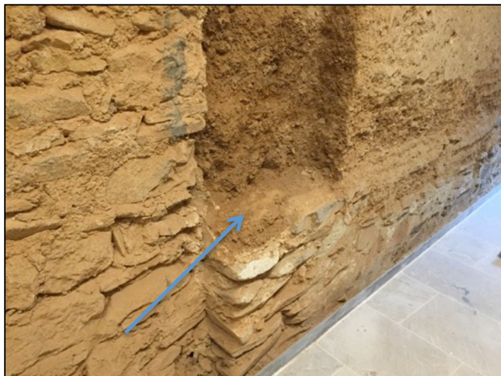
Fotografia 8. Vista del mur de tàpia UE171 des de l'estança A1 amb sòcol de pedra i tapial.
