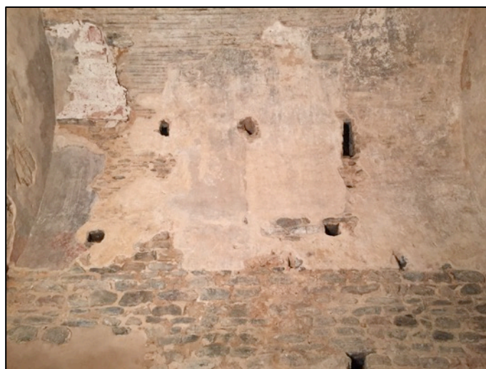
Fotografia 110. Vista mur UE1005 i volta UE1008 amb enlluït medieval juntament amb diversos forats de bastida i finestres UE1044 i UE1062. Forat d'accés pis superior torre tapiat UE1070.
