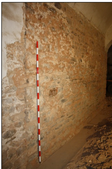
Fotografia 68. Mur occidental torre vist des de l'exterior amb Alteracions de morters més moderns.
