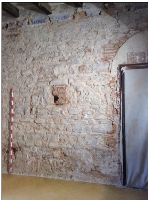
Fotografia 97. Vista cara externa mur nord en el tram del primer pis de la torre romànica.
