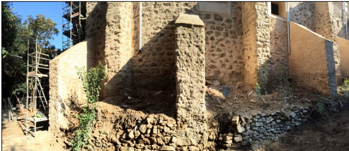
Fotografia 61. Sanejament subsòl en sector dels contraforts s. XVIII masia.
