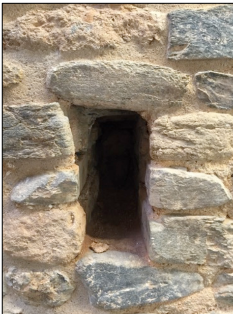
Fotografia 122. Detall cara externa finestra UE1058 localitzada en mur 1005.
