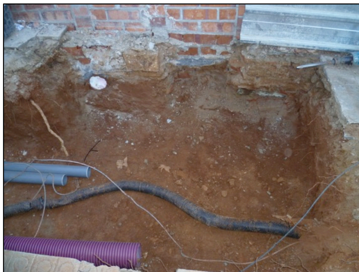
Fotografia 163. Arqueta de connexió serveis amb masia Can Fargas.
