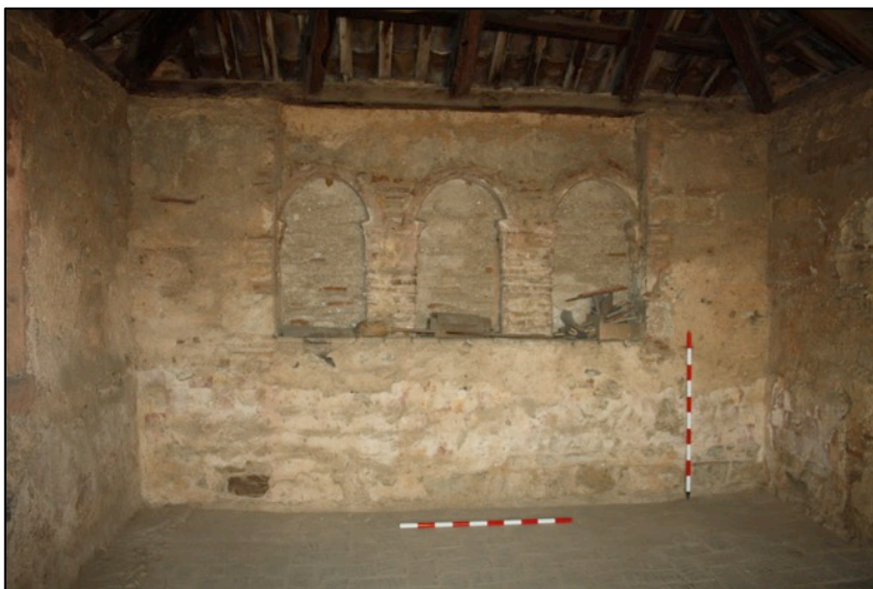
Fotografia 127. Murs UE1003 i UE1106 amb finestres trigèmimes s. XVII tapiades.
