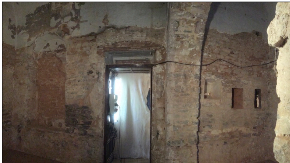
Fotografia 84. Vista general mur nord amb arc de mig punt UE1052.
