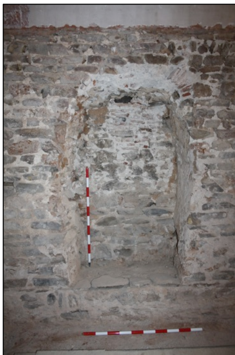
Fotografia 76. Vista de la porta d'accés a la torres oberta en el segle XII UE1066 i posteriorment tapiada s. XIX UE1069.
