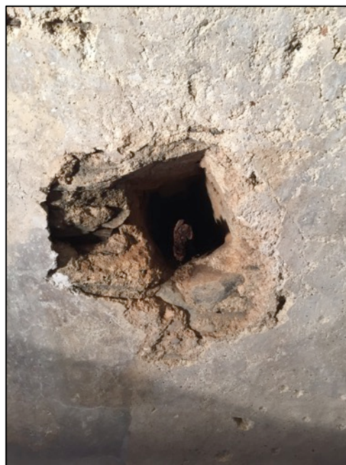
Fotografies 113, 114 i 115. Detall de diversos forats de bastida localitzats al llarg dels paraments de la torre. UE1150 amb restes de fusta.
